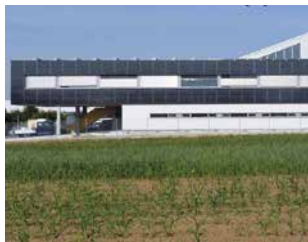
EnFa – Die Energiefabrik Widmann Energietechnik GmbH www.widmann-energietechnik.de
