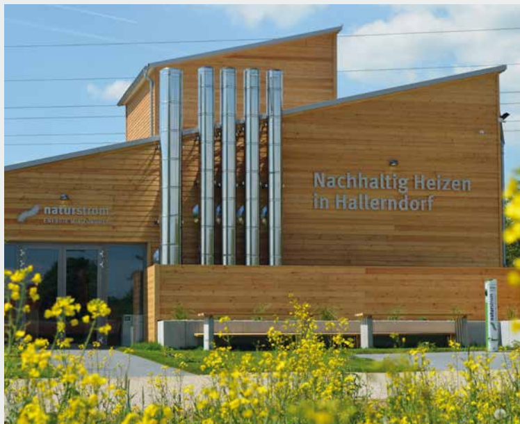
In der Energiezentrale am Hallerndorfer Kreuzberg (Oberfranken) wird erneuerbare Wärme erzeugt. Quelle: NATURSTROM AG
